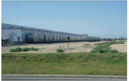
圖七、公司後方冷鏈列車裝貨之情形。
