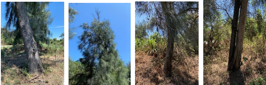
傾斜及樹幹腐朽 樹冠部枯頂 樹幹彎曲 樹幹健全(左)枯幹(右) 圖 5 步行式目視樹木檢查評估
