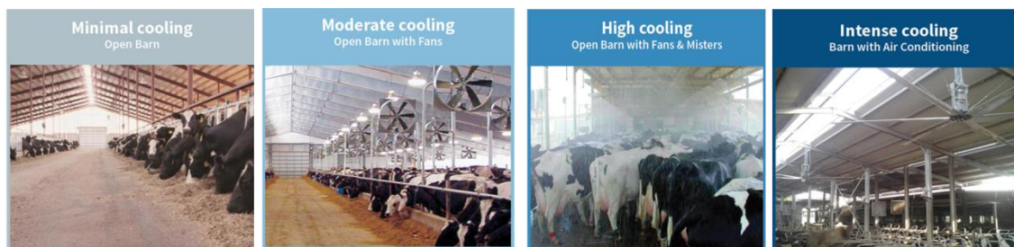
圖 8. 牛舍的四種不同降溫級別。由左至右分別為最小降溫：開放式牛棚。中度降溫：開放式牛棚+風扇。高度降溫：開放式牛棚+風扇+噴霧。強烈降溫：室內空調牛棚。
