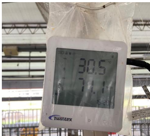
南庄畜牧場傳統式豬舍內裝設紀錄型 溫濕度計
