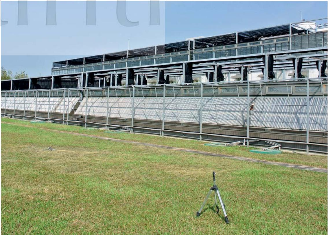
作物溫度逆境模擬試驗平臺溫室外觀為玻璃溫室，具有雙層遮陰網，可依照試驗需求，自動開啟或關閉。
