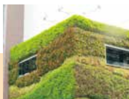
綠牆運用情形 台中市勤美誠品大樓外牆
