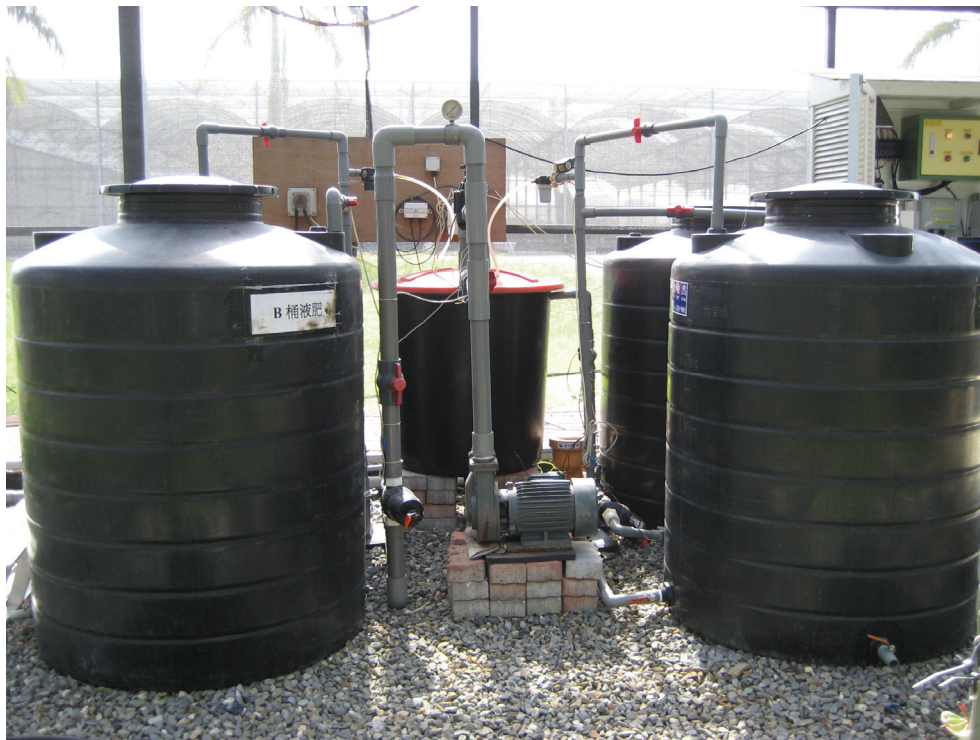
圖 1. 大量桶/批次攪拌式肥灌控制系統架構 (上) 與實況 (下)。
