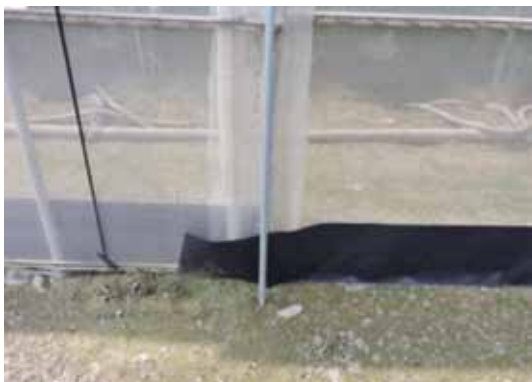
圖三、橡膠片圍繞牆角。
