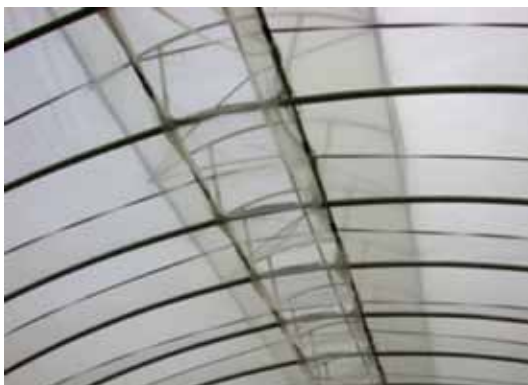
圖五、太子樓：紗網與塑膠布交界處應密合。
