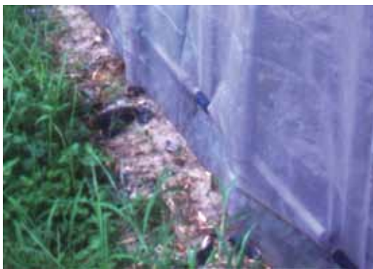
圖二、牆角的紗網長度應加長，並埋入土中。
