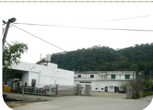
圖 1. 臺中豐原處理場。
