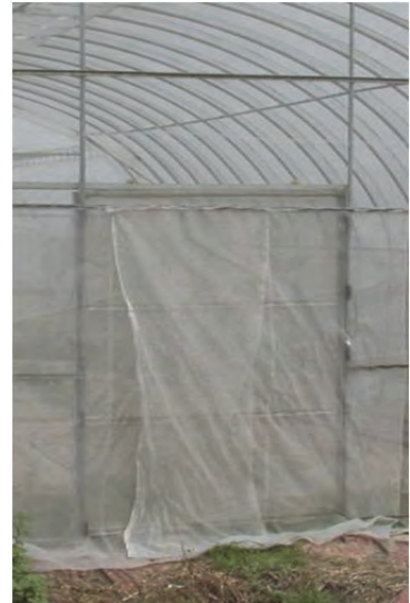
圖 1. 門禁：除原有的拉門，另加兩層交錯重疊覆蓋的紗網 (仿蚊帳)。
