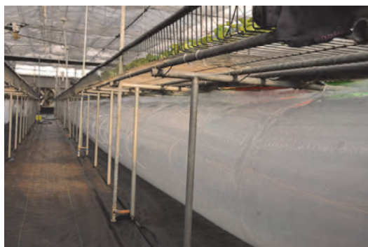
圖 4. 送風管路 (軸流風扇和 PEP 利得膜風管設置)。
