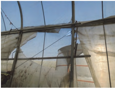
圖 4. 牆面紗網有破洞。
