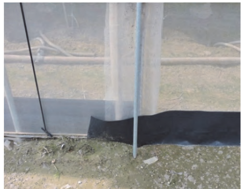
圖 2. 牆角的紗網長度應加長，並埋入土中。 圖 3. 橡膠片圍繞牆角。
