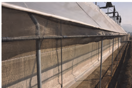
圖 3. 多元隔離關鍵濾材和外遮陰系統。
