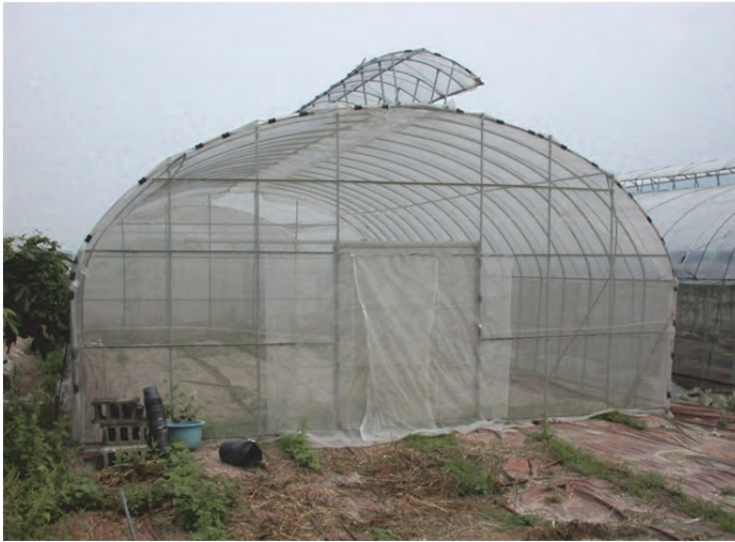
圖 1. 門禁：除原有的拉門，另加兩層交錯重疊覆蓋的紗網 (仿蚊帳)。
