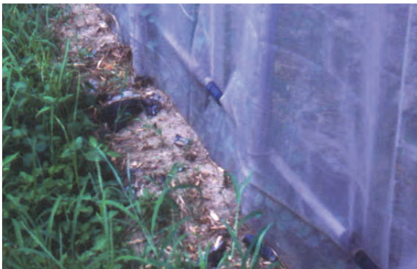
圖 2. 牆角的紗網長度應加長，並埋入土中。 圖 3. 橡膠片圍繞牆角。
